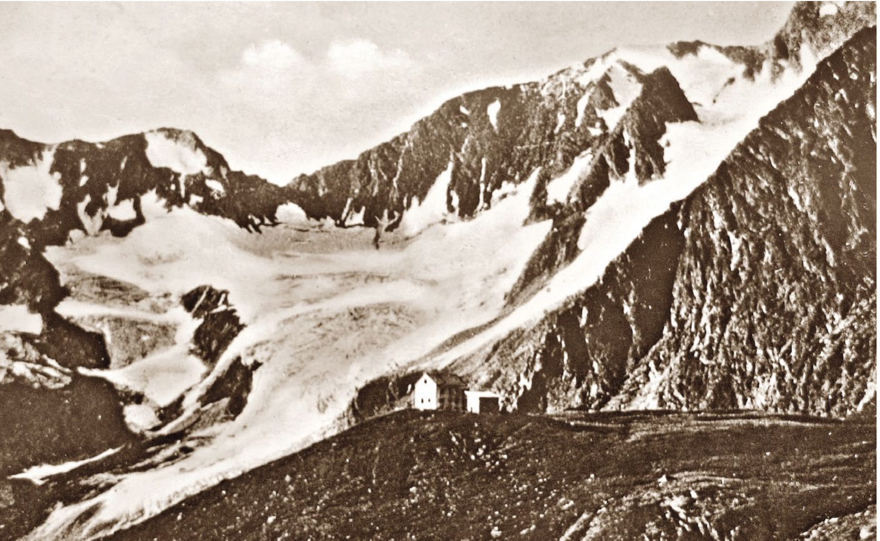
Essener Hütte mit Seeber Ferner Il rifugio Essener Hütte col ghiacciaio Seeber Ferner Shelter hut Essener Hütte with glacier Seeber Ferner (anno 1930, Pfitscher Roman, St. Leonhard)
